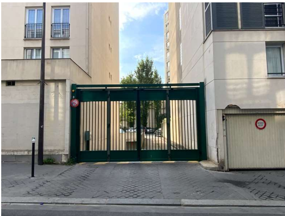
Entrée principale parking côté rue Léon Giraud
